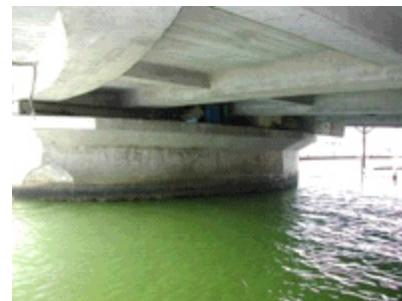
Pont construit sur des eaux agressives.
