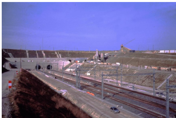
Tunnel sous la Manche (FRANCE)
